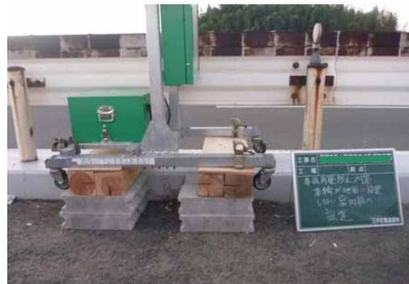
キャスター部分が地覆に設置しないよう直接土台を支持し安定した固定方法に変更した
