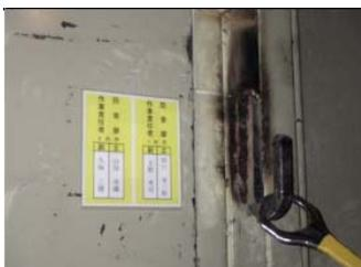
3名での固定作業を作業手順書に記載する。チェーン取付箇所を防音扉を抑える力が緩まってもチェーンと扉の間に指が挟まらな構造に変更
