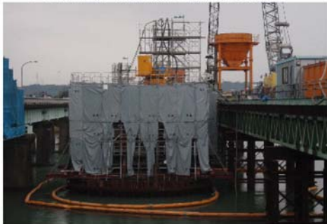
P3橋脚全景(左岸側P2橋脚より撮影)
