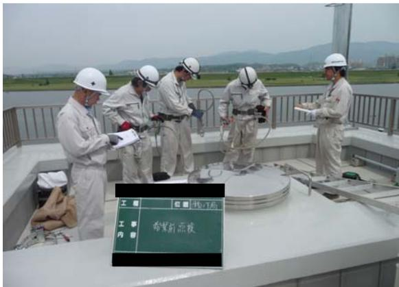
高所作業前に、安全バンドのメインロープと補助ロープを必ず使用して、どちらか一方のフックが常にかかっている状態で移動することを高所作業を行う作業員に対して教育を行い徹底させる。
