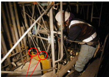
パネル吊クランプ パネル吊クランプを使って 型枠パネル吊上げ状況
