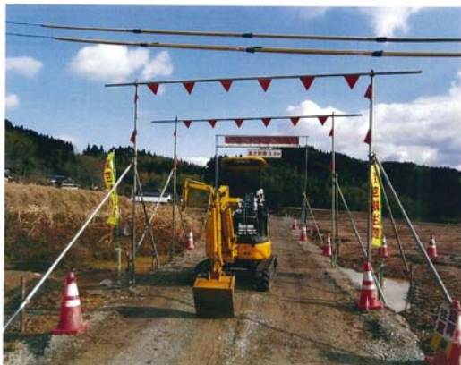
対策① (小型バックホウの使用) 0.1m3級
