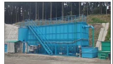
・事故発生前の状況
