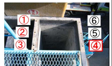
・昇降階段のボルト固定箇所 (事故発生時は④のみ仮止め)
