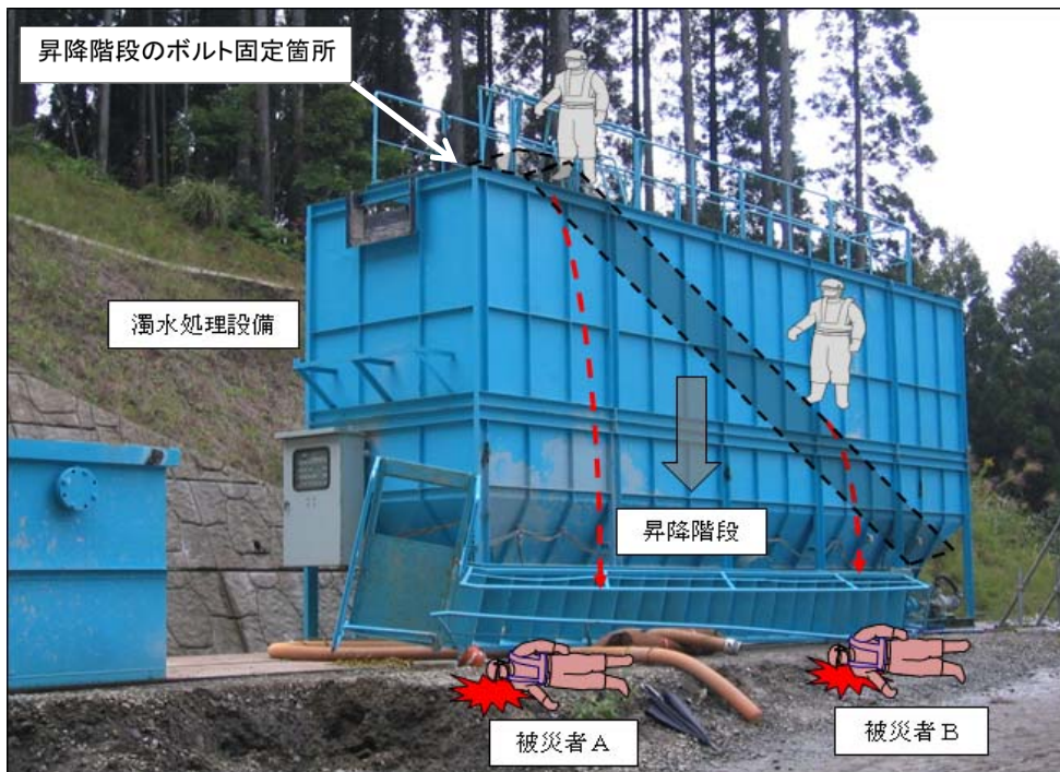
・昇降階段のボルト固定箇所 (事故発生時は④のみ仮止め)
