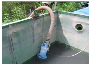
被災時の水中ポンプの状況
