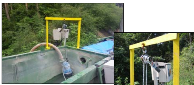
①荷揚げ装置(レバーブロック)の設置
