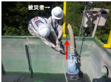
①水中ポンプの引き上げ
