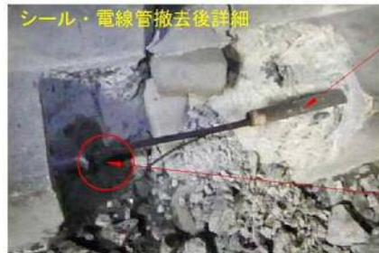
電線管φ28mm、外径35mm
