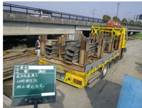
切断鋼矢板の運搬を行うユニック車の荷台に架台を設置し、鋼矢板の最大積み重ね枚数の上限は、継施工の補強板があるため4枚とする事で転倒防止対策を行う。
