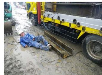
現場にて鋼矢板の積込作業中にユニックから作業員(運転手兼玉掛者)が転落し、被災した。
