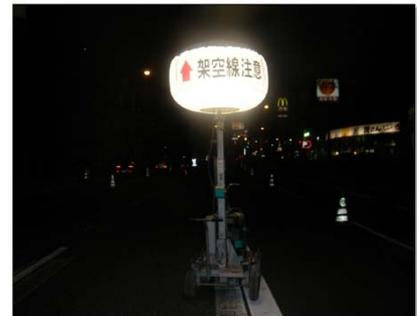
架空線見落とし防止対策のため、「架空線注意」と記載されたバルーンライトを設置する。
