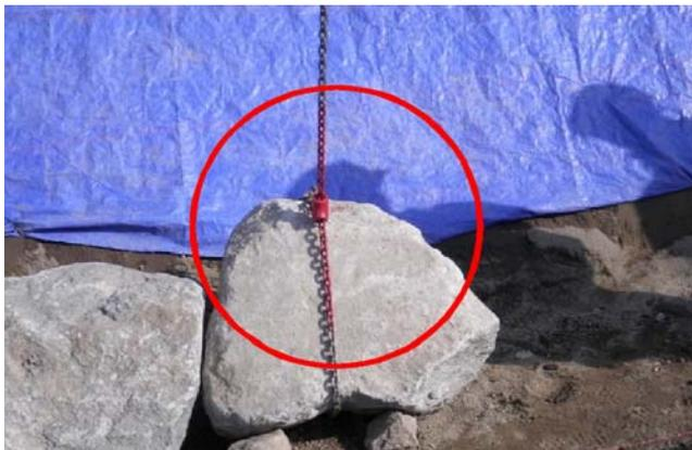
・玉掛けチェーンスリングの貫通金具より上下30cm程度を着色し、転石が完全に据え付けるまでは、その範囲を手で掴まないようにする。
