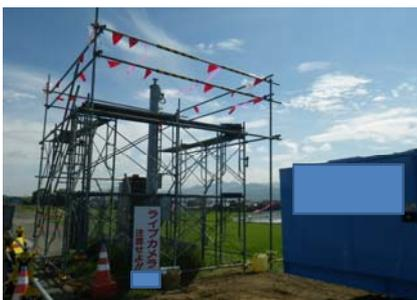
監視カメラの周囲を枠組み足場で囲み、三角旗、看板を設置し、注意喚起をする。
