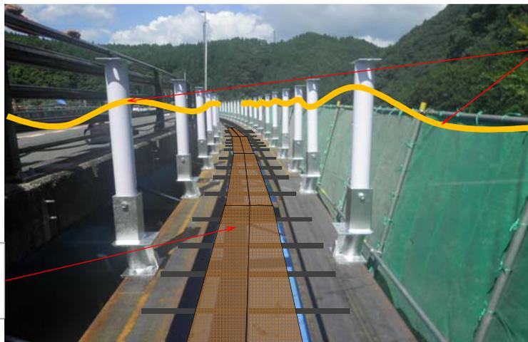
主桁間を飛び移らないように主桁間に作業床を設ける。
