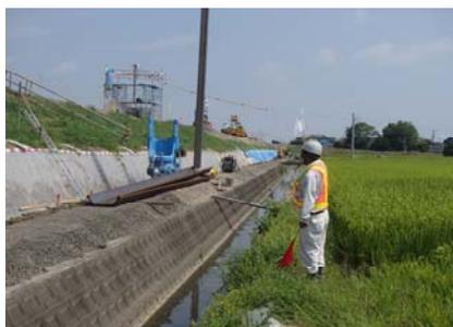
クレーン作業の合図者は、紅白手旗、呼笛を使いオペレーターに明確な合図を出す。
