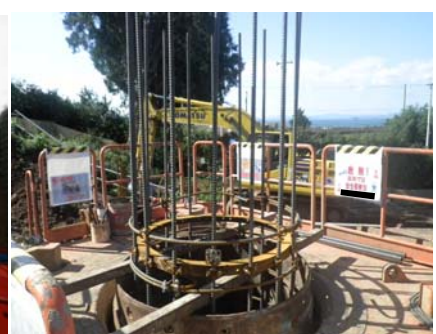
四角鋼管の使用
