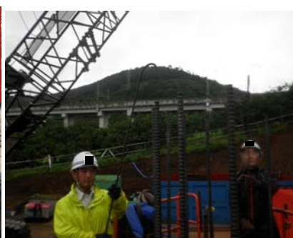
架台の上から介錯鉄筋の使用を徹底する。
