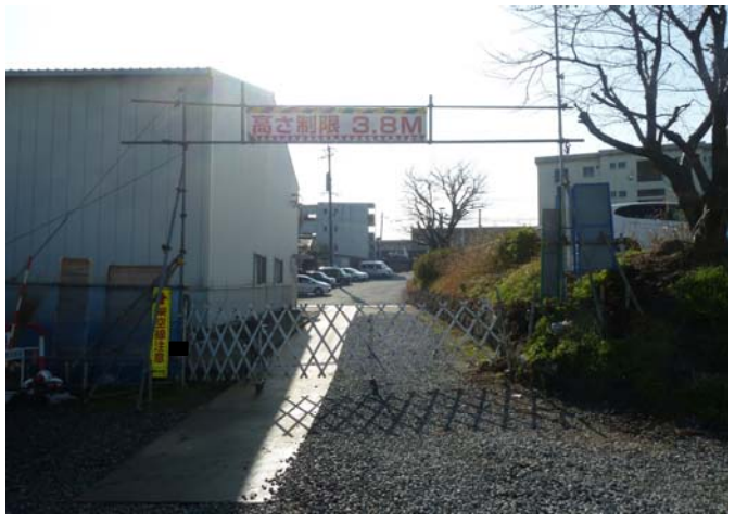
高さ制限ゲートを単管にて設置
