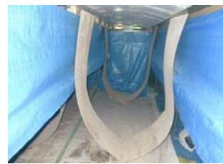
【薄ベニヤ設置状況】
