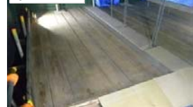
①足場板全面敷き
