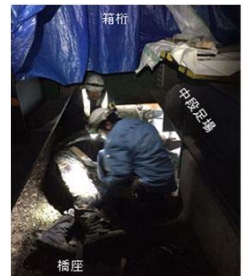
【被災者の状況(橋座上)】
