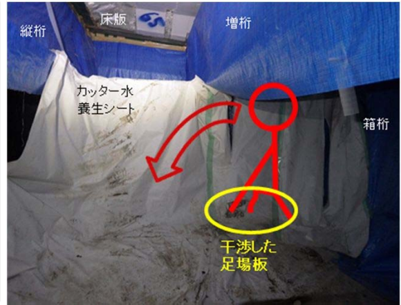
【干渉する足場板を移動する状況】
