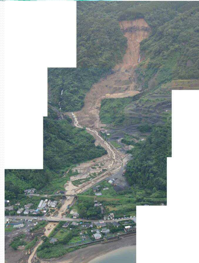
平成27年 垂水市深港地区
