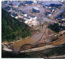
堤防決壊に伴う氾濫流による家屋倒壊等
