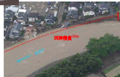
河岸侵食に伴う家屋倒壊等
