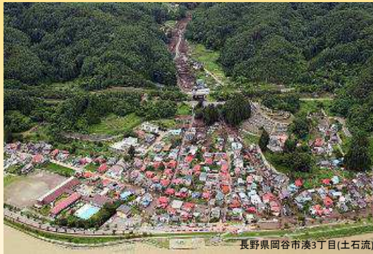
長野県岡谷市湊3丁目(土石流)
