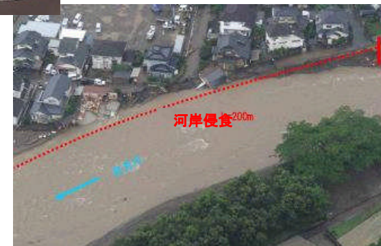
河岸侵食に伴う 家屋倒壊等
