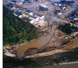
堤防決壊等に伴う氾濫流による家屋倒壊等
