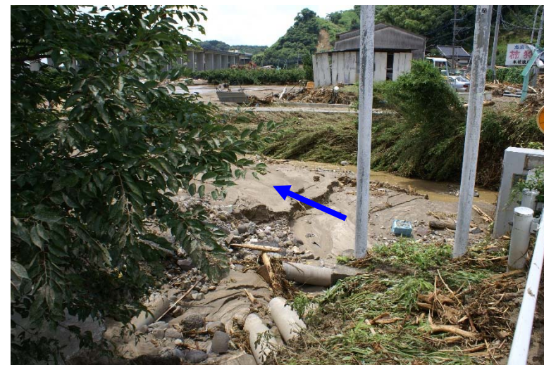
本陣橋下流側: 土砂の堆積
