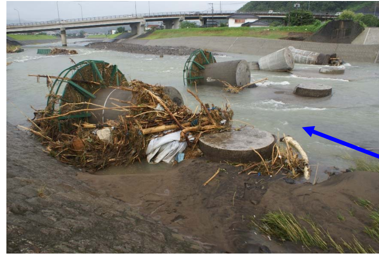
折れた橋脚(4基)
