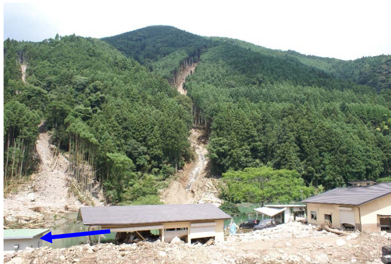
大規模崩壊地上流側の斜面崩壊
