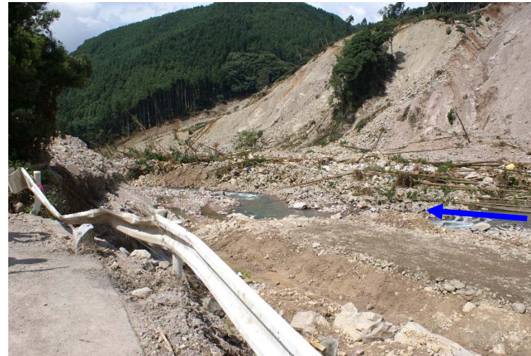
天然ダム堤体上流端
