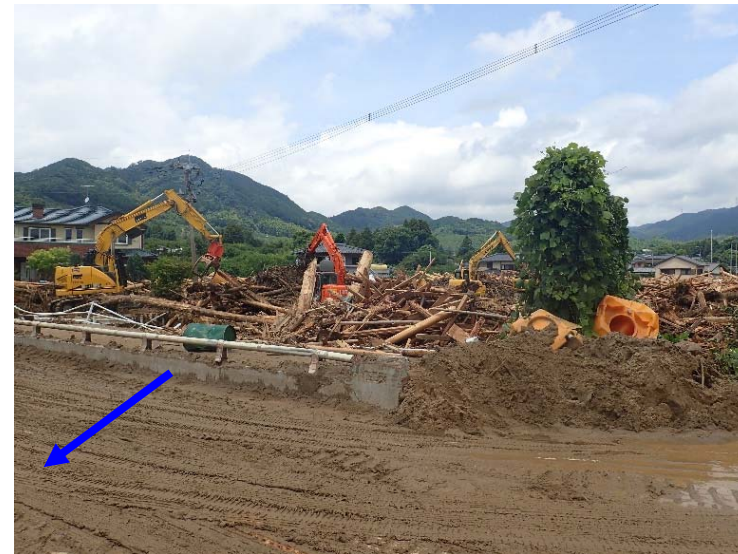
本陣橋上流側の流木集積
