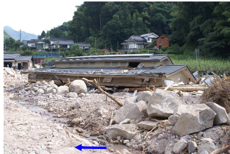
天然ダム堤体下流:家屋の倒壊。
