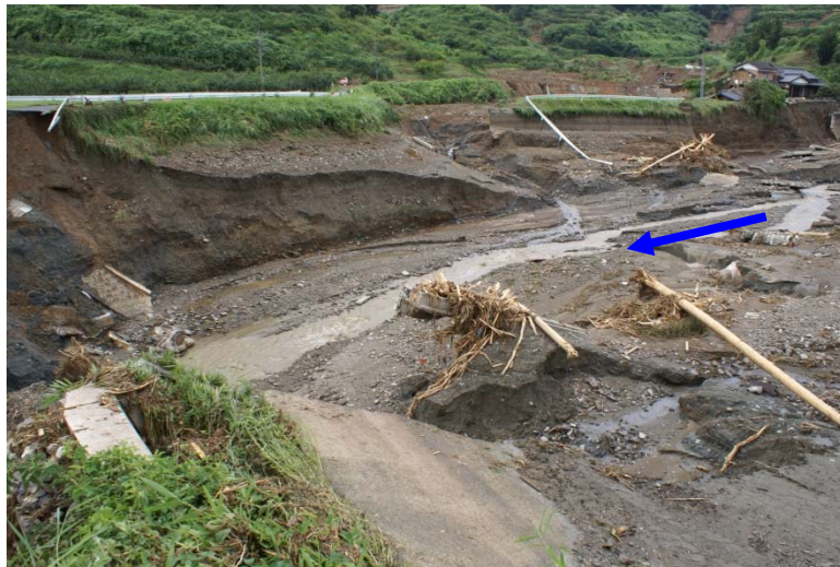
溜池右岸側の護岸の損傷
