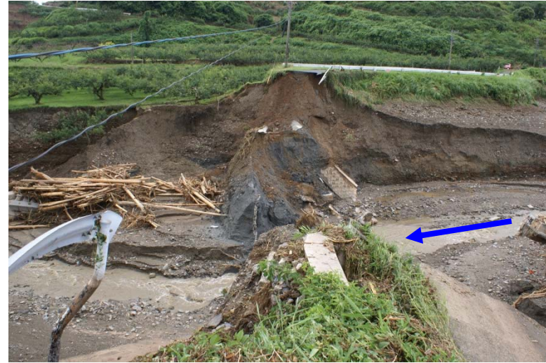
溜池堤体右岸側断面
