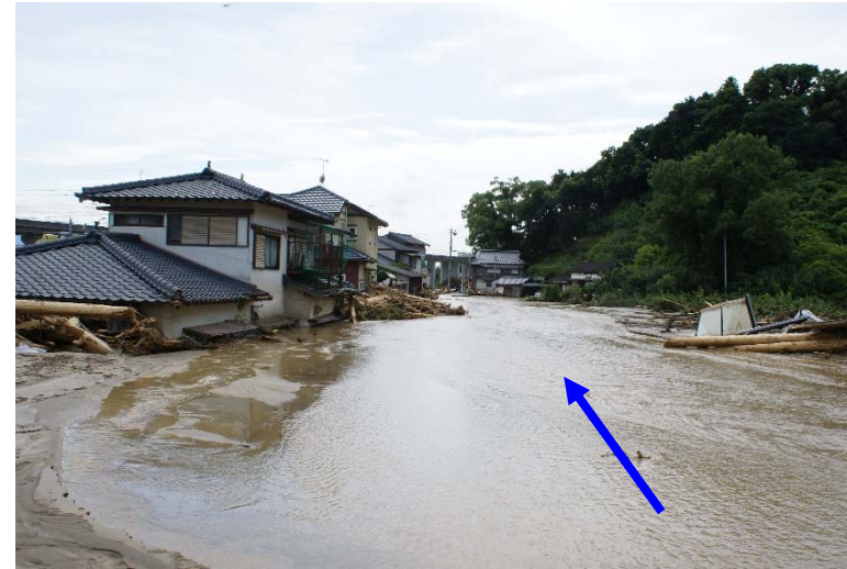
本陣橋上流の家屋埋没状況
