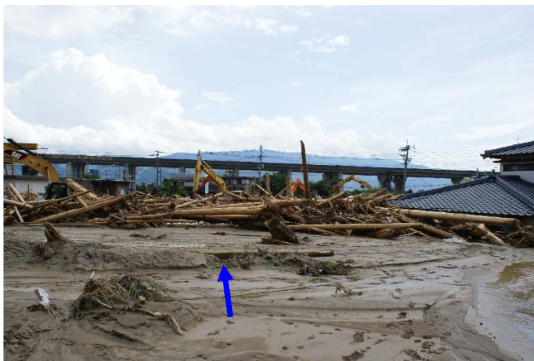
本陣橋上流側から: 大量の土砂と流木の堆積
