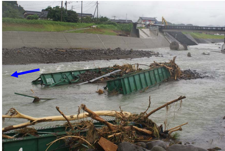
河道に落下している橋桁部
