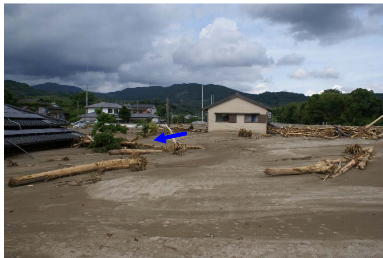
本陣橋上流の家屋埋没状況
