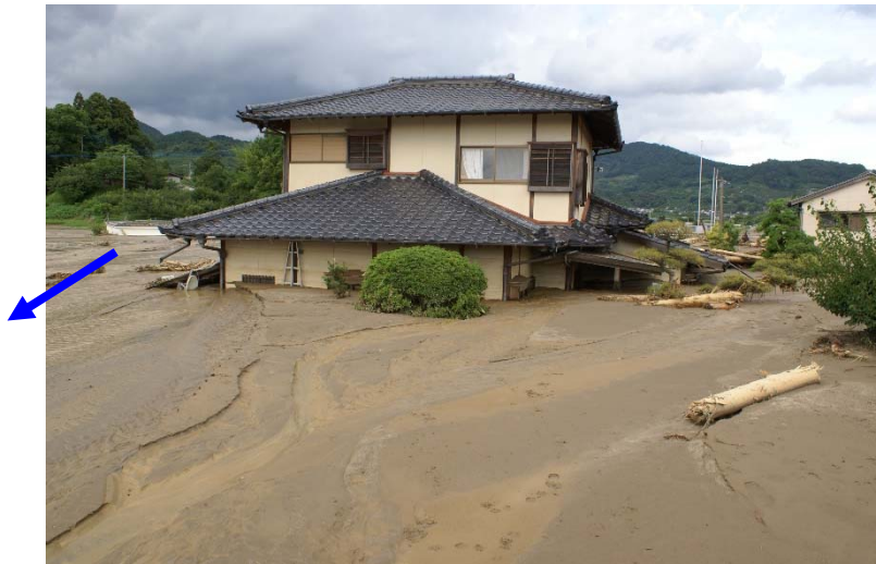
本陣橋上流の家屋埋没状況
