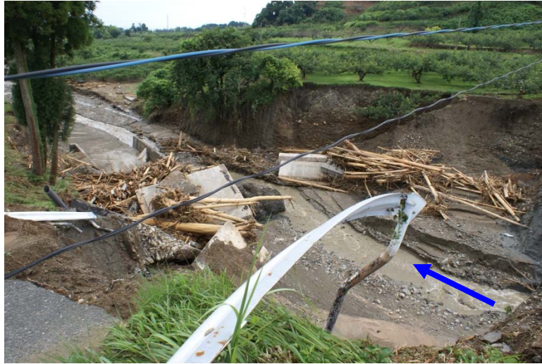
溜池堤体左岸と下流
