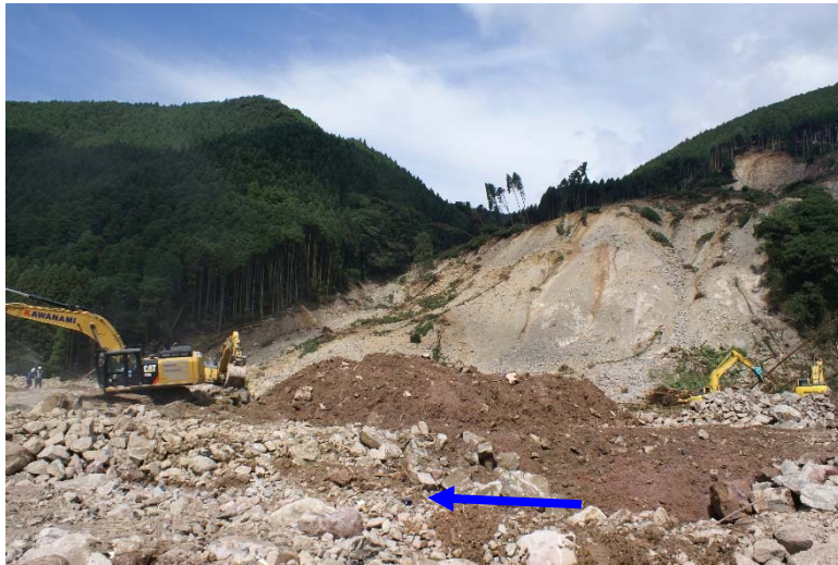
土砂と流木の撤去を行い、河道の維持を図っている
