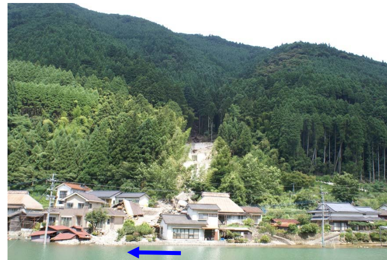
さらに上流の斜面崩壊:3連の砂防ダムが満砂状態
