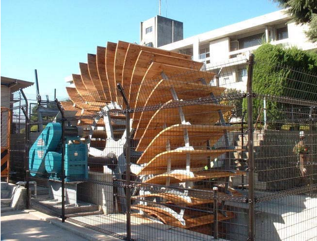
写真：山梨県都留市家中川小水力市民発電所「元気くん1号」
