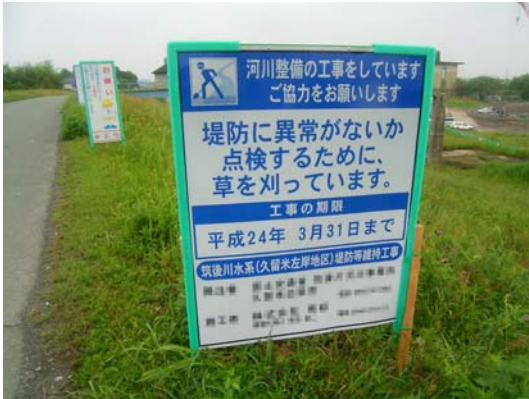
堤防除草工事の事例
