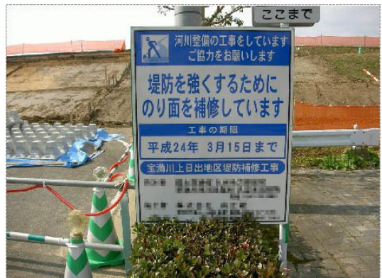
法面補修工事の事例
