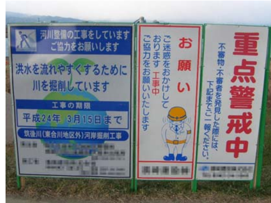
河道掘削工事の事例
