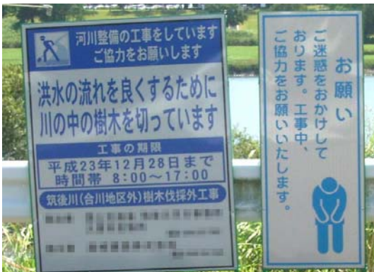
樹木伐採工事の事例
