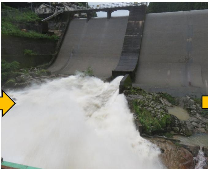
令和3年8月出水時の下田ダム排砂ゲート開放(図中①)
