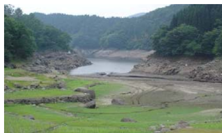
少雨のため水位が大きく低下した芹川(せりかわ)ダム(平成17年)
