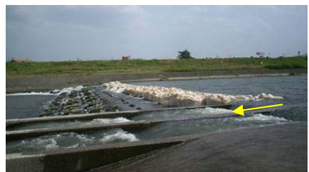
上水の取水のため土のうを積んだ府内(ふない)堰(平成17年)
