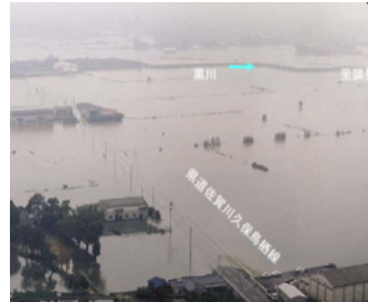
昭和57年7月洪水(佐賀市金立町付近)
