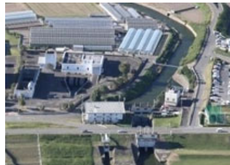
筑後川ポンプ場
