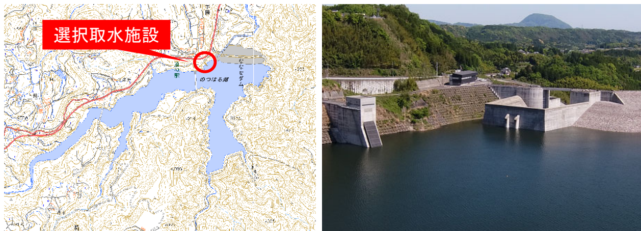
図5-23 選択取水設備位置図及び写真
