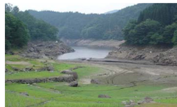
小雨のため大きく水位が低下した芹川ダム (平成17年)
