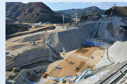
平成27年12月 ダム建設中の状況
