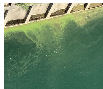
選択取水設備付近の緑色浮遊物(R5.9月)
