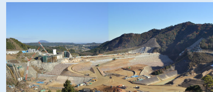
平成28年12月 ダム建設中の状況
