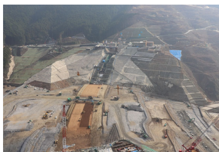
平成30年10月 本体工事中
