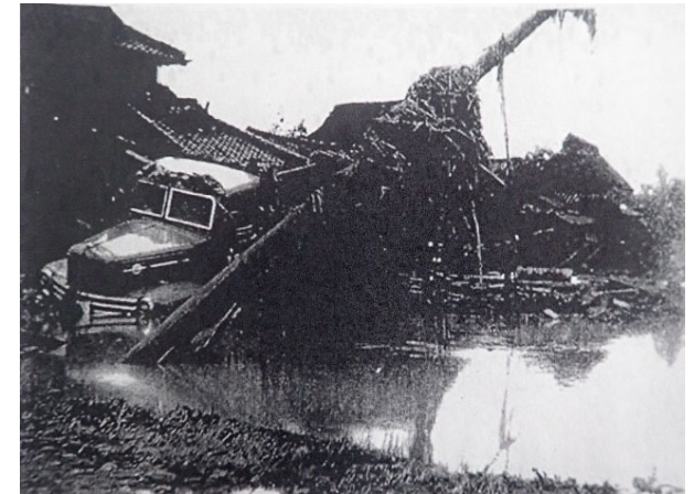
小石原川の支川二俣川合流点付近の被害状況（昭和28年6月）
