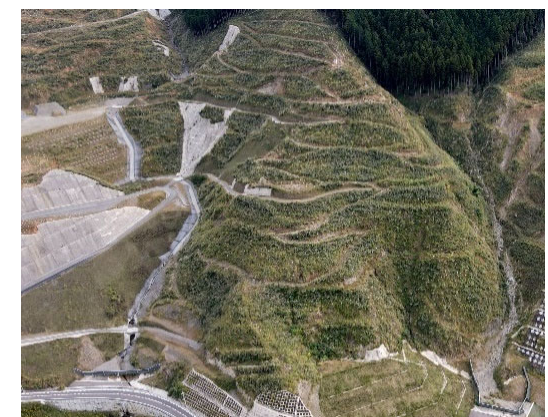
ドローンによるコア山中央部斜め写真(令和5年9月)
