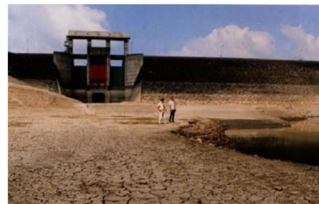
干上がった寺内ダム（平成6年渇水）
