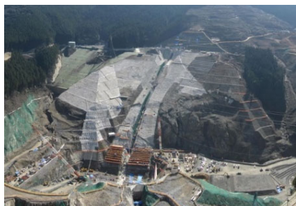
平成29年10月 本体工事中
