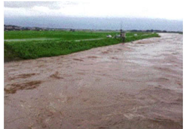
栄田橋観測所の状況(平成24年7月)
