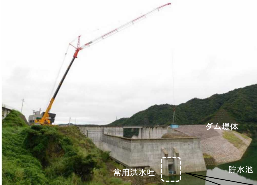
非洪水期の常用洪水吐閉塞状況
