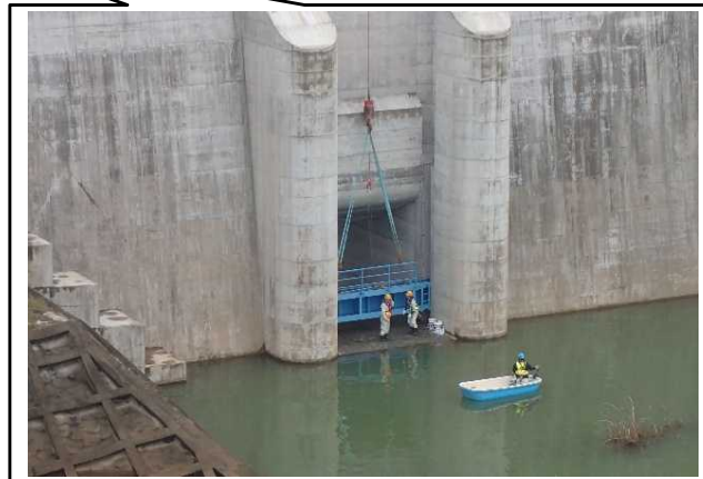
非洪水期の常用洪水吐閉塞状況
