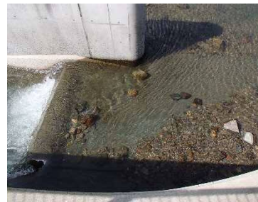
魚道出口の状況(R5.5月) ※魚道出口の土砂堆積は少ない
