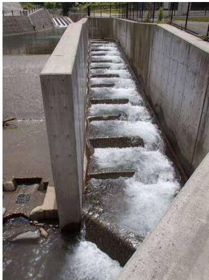
魚道の状況(R5.5月) ※魚道内に土砂の堆積なく通水
