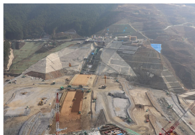
H30.10 本体工事中
