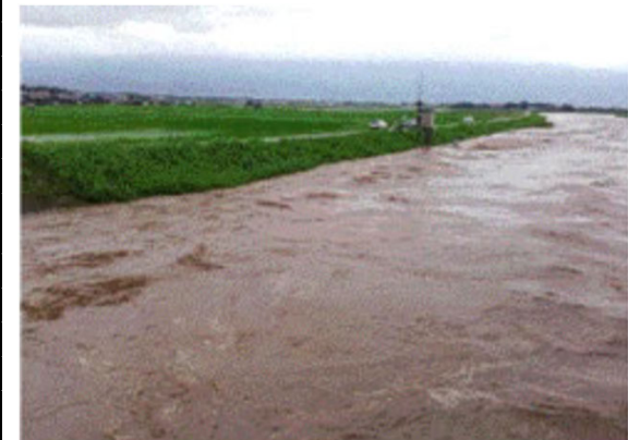
栄田橋観測所の状況(平成24年7月)
