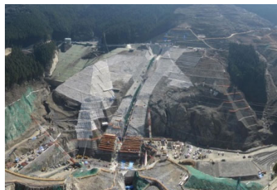
H29.10 本体工事中
