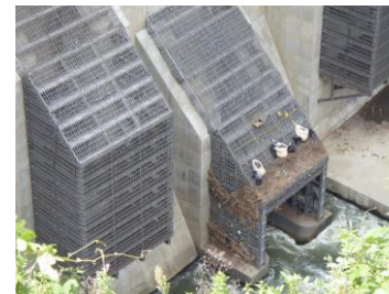
塵芥除去状況 (令和6年8月撮影)
