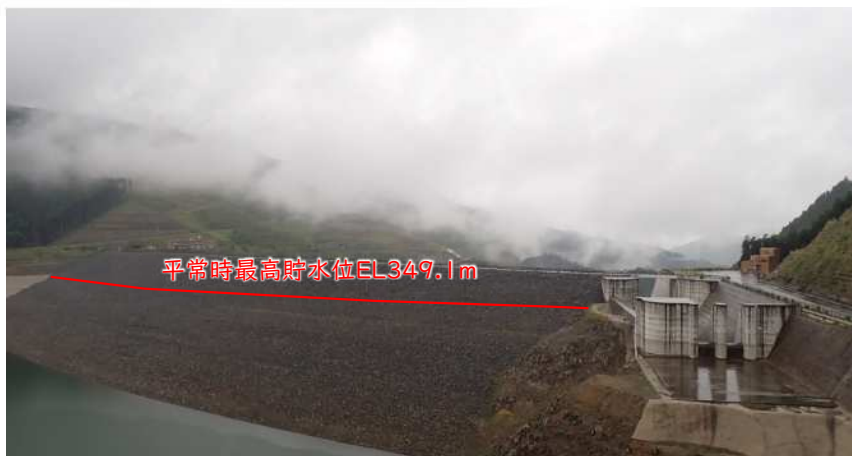
小石原川ダム現状(R8.6.4:EL314.30m)
