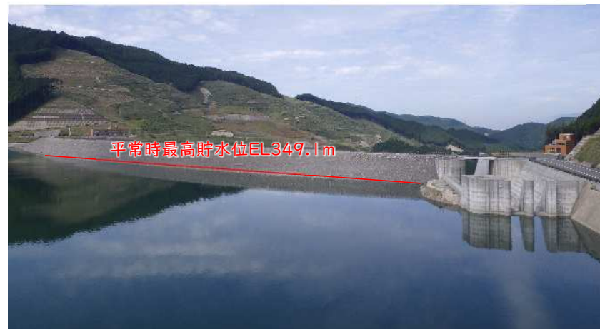
平常時最高貯水位付近の状況(R7.6.6:EL348.39m)
