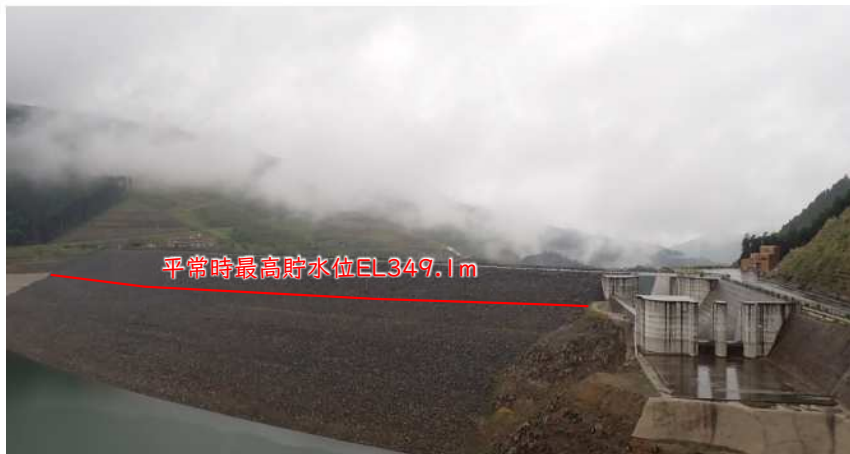
小石原川ダム現状(R8.6.4:EL314.30m)
