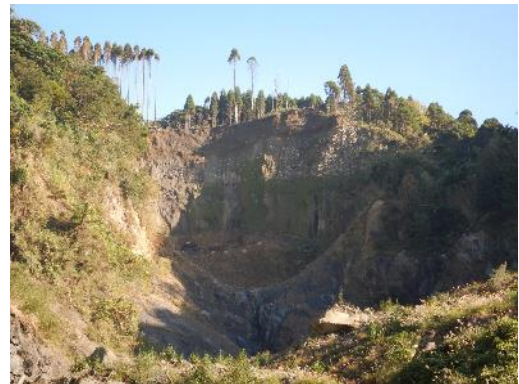
地形地質特性の確認 (埋没谷=地下水集中箇所)
