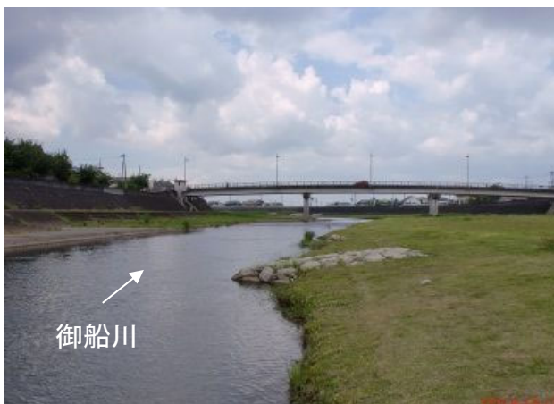
護岸の緩傾斜化により水際の安全性が大幅に向上
