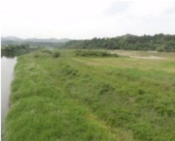
広大な高水敷に雑草が繁茂し、安全に水辺に近づくことが困難。
