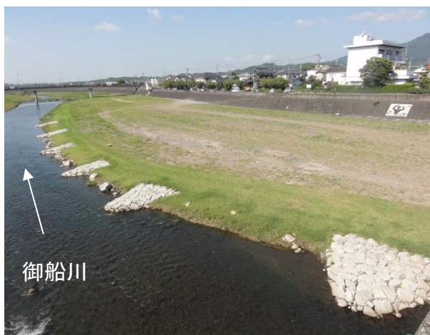
護岸の緩傾斜化により水際の安全性が大幅に向上
