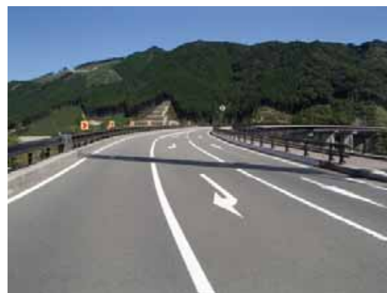
付替道路整備状況(他ダム事例)
