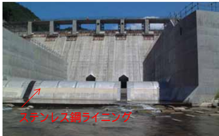
堤体摩耗対策(他ダム事例)
