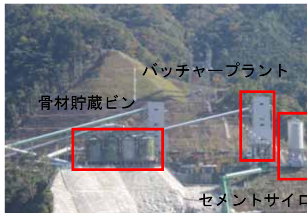
コンクリート設備全体写真 (他ダム事例)
