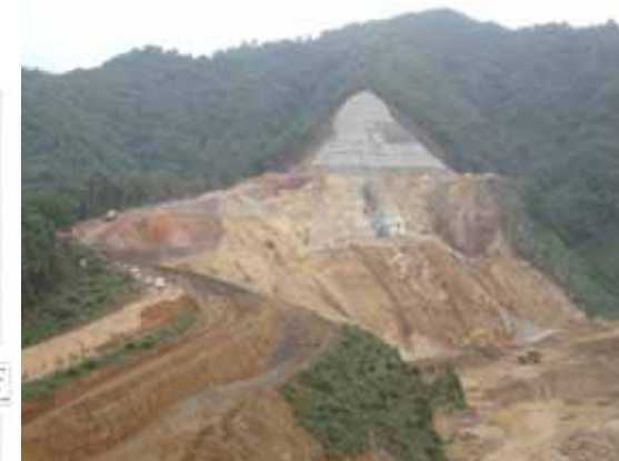
基礎掘削状況 (他ダム事例)
