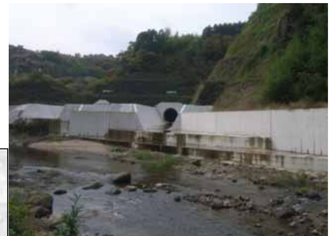
仮排水路トンネル（他ダム事例）
