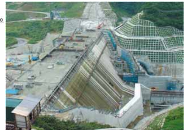
打設状況 (他ダム事例)
