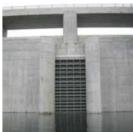
試験湛水ゲート設置状況(他ダム事例)
