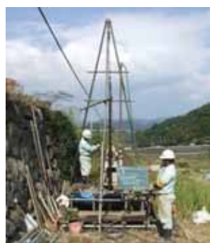
地質調査状況写真
