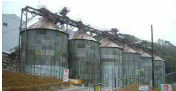
骨材設備写真 (他ダム事例)
