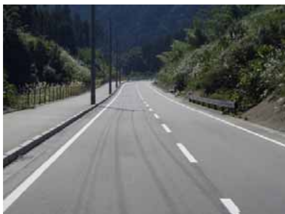
付替道路整備状況(他ダム事例)
