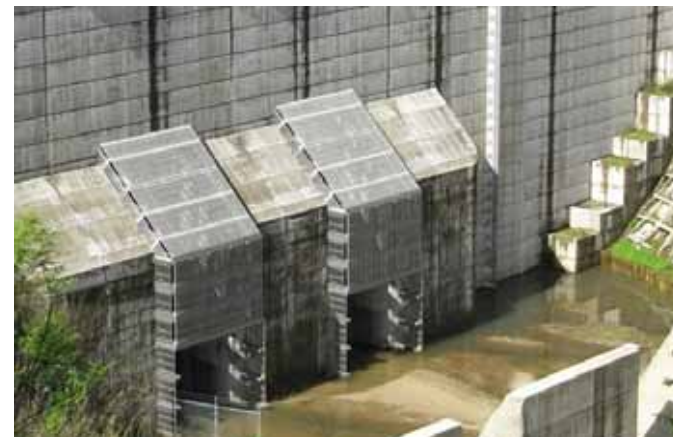
鋼製スクリーン(他ダム事例)
