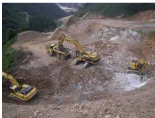
原石山掘削(他ダム事例)
