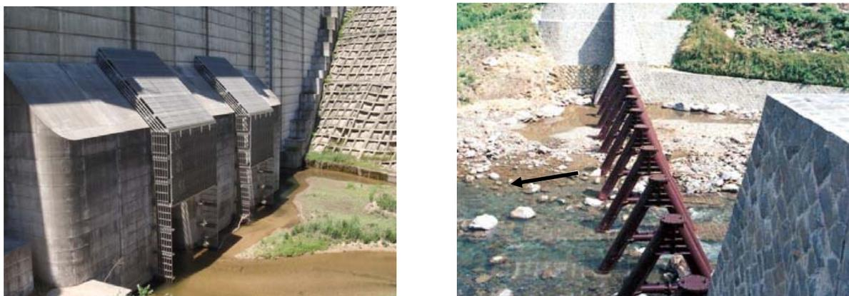
図 3.1-5 スクリーン及び流木捕捉施設イメージ
