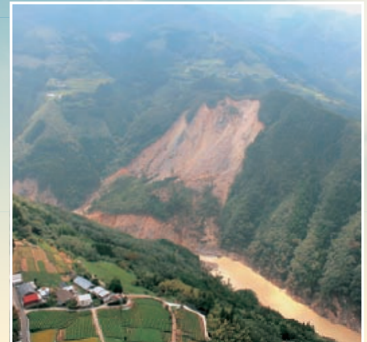
耳川天然ダム災害
