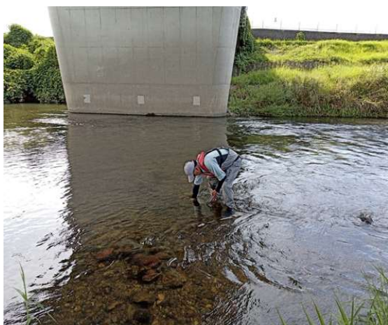
七瀬川 露橋 直営
