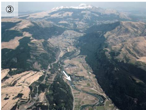
写真 2.1.3 白川中流部 [大津町瀬田 せた 付近]
