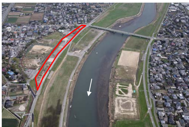
写真 2.3.5 小島河川防災ステーション整備位置 〔熊本市小島付近〕
