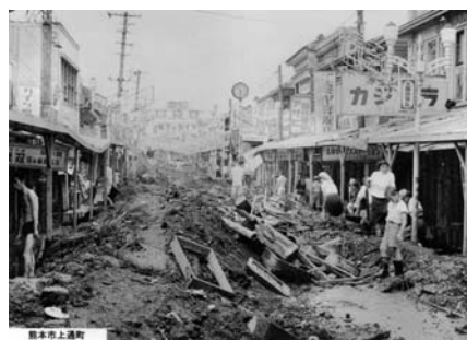
写真 2.2.2 洪水後のヨナの堆積状況(熊本市上通町)
