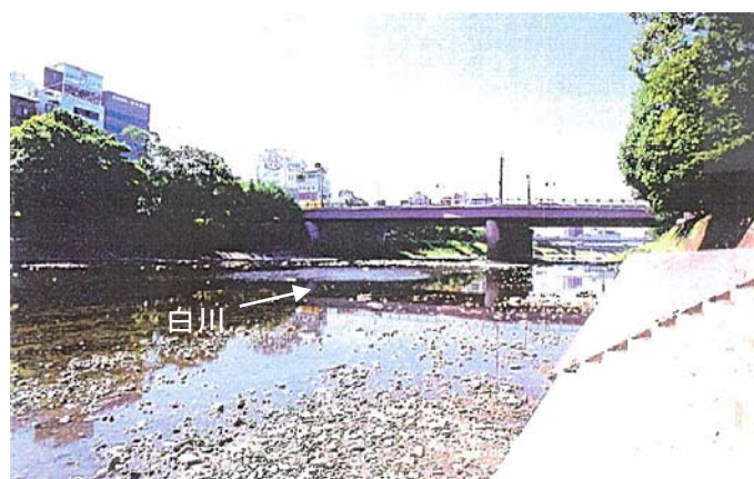
写真 2.2.16 平成 6 年渇水時の瀬切れの状況（大甲橋 たいこう 上流）
