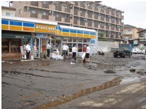
写真 2. 2. 14 洪水後のヨナの堆積状況 (熊本市黒髪地区)
