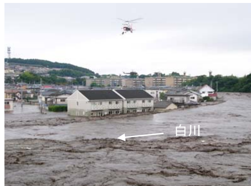
写真 2. 2. 13 熊本市龍田陳内地区の越水状況
