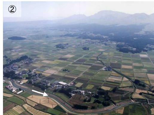
写真 2.1.2 支川黒川 [阿蘇市乙姫 おとひめ 付近]
