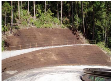
〈工事完成直後〉
