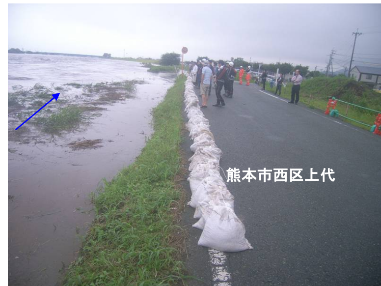
熊本西大橋下流右岸付近の状況 (7/12 11:01)
