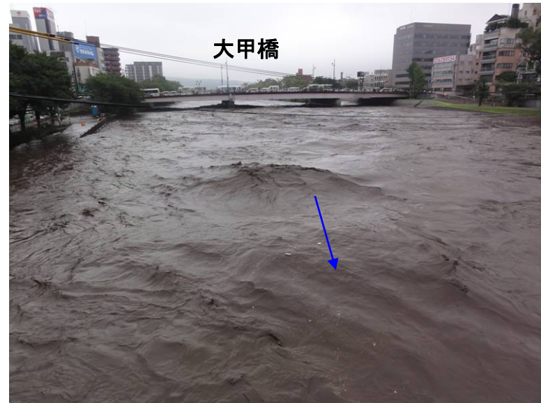
大甲橋下流の流下状況 (7/12 11:31)
