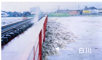
写真 2.2.8 第一白川橋梁地点の流下状況
