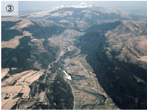
写真 2.1.3 白川中流部 [大津町瀬田 せた 付近]
