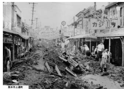
写真 2.2.2 洪水後のヨナの堆積状況(熊本市上通町)
