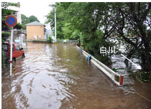
写真 2. 2. 10 明午橋右岸上流の越水状況
