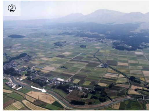
写真 2.1.2 支川黒川 [阿蘇市乙姫 おとひめ 付近]
