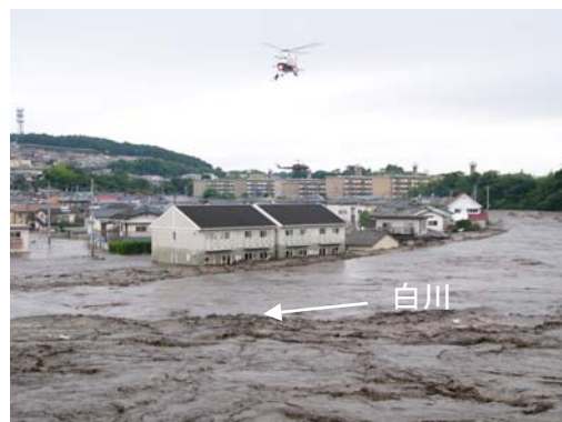
写真 2. 2. 13 熊本市龍田陳内地区の越水状況
