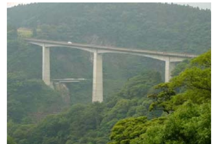
写真 3.3.1 阿蘇長陽大橋 (平成5年3月完成)
