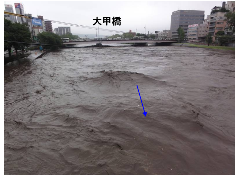
大甲橋下流の流下状況 (7/12 11:31)
