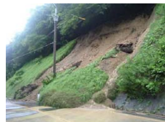
被災状況写真
