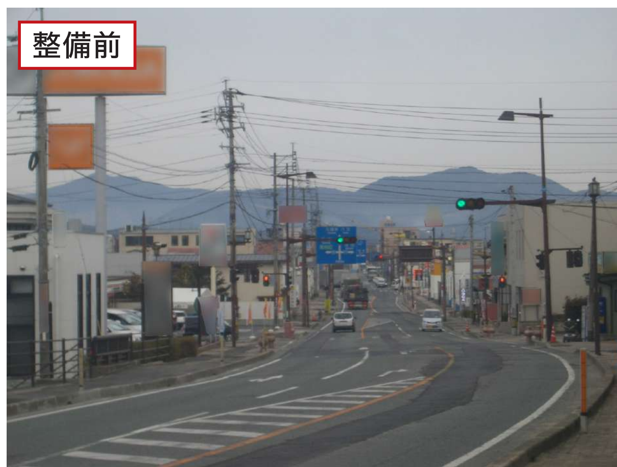
国道3号 熊本県山鹿市
