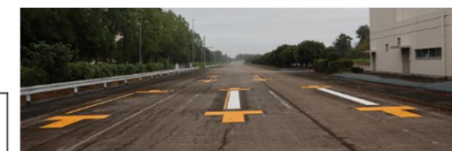
予備実験(踏切内)の誘導表示等の敷設状況
