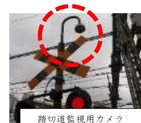
踏切道監視用カメラ
